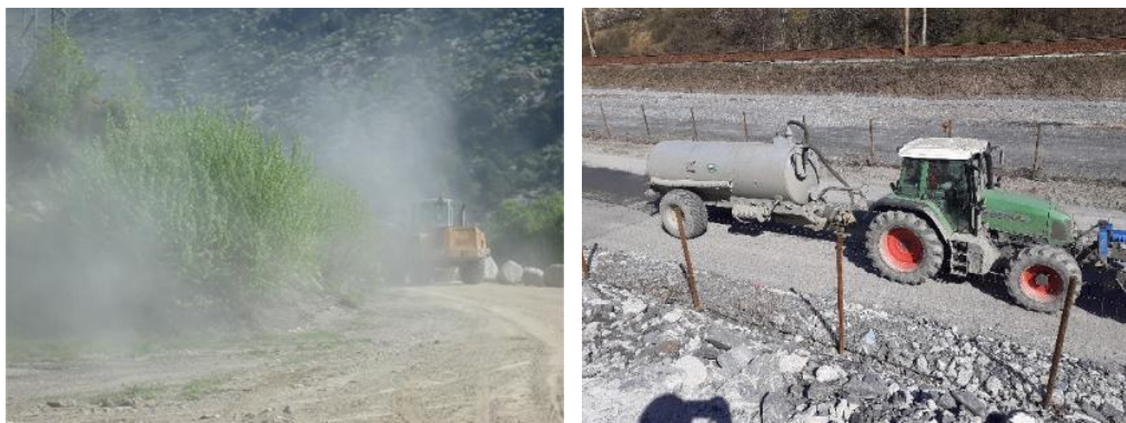
Photo 1 : Exemple d'émission de poussières et d'arroseuse en phase chantier
