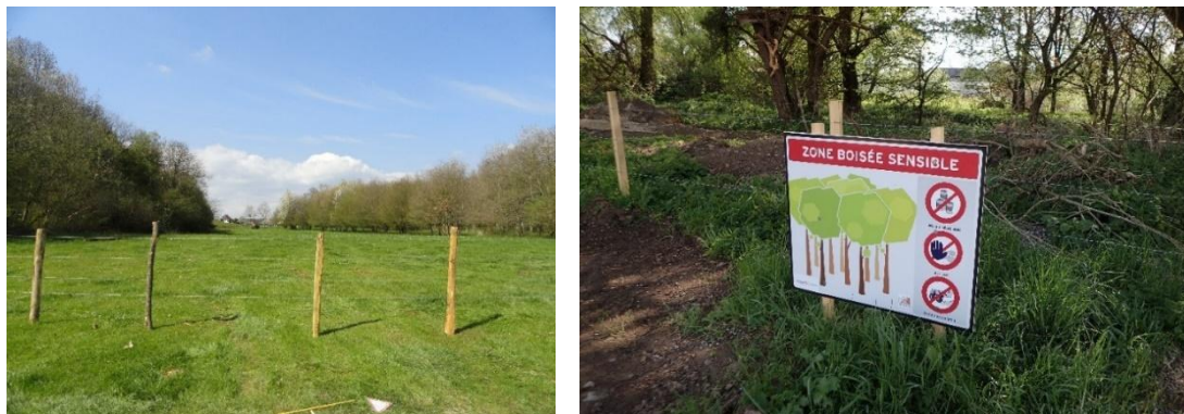
Figure 1 : Exemple de mise en défens de site sensible et de matérialisation des emprises travaux
